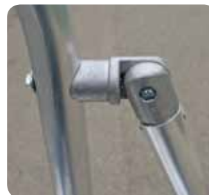
Massive Geländerverbindung.
